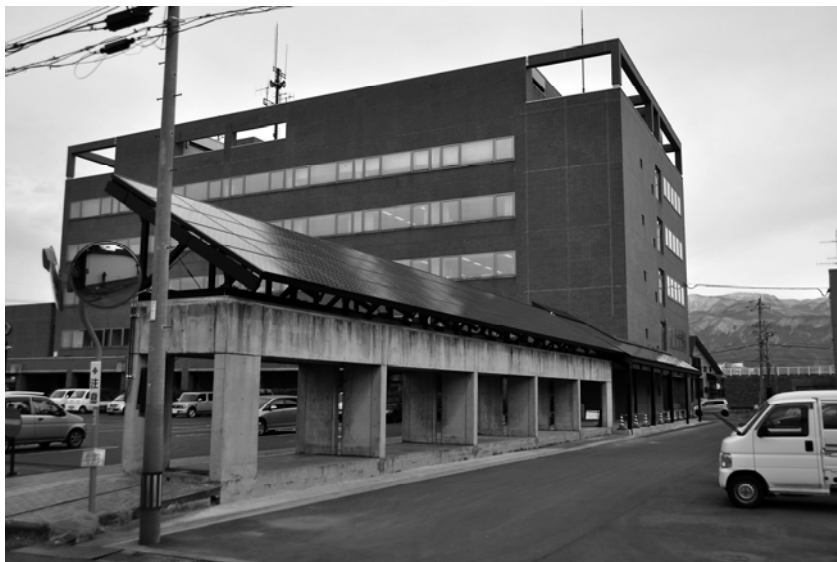
飯山市役所に設置された太陽光発電パネル （平成 23 年 12 月から稼動）
